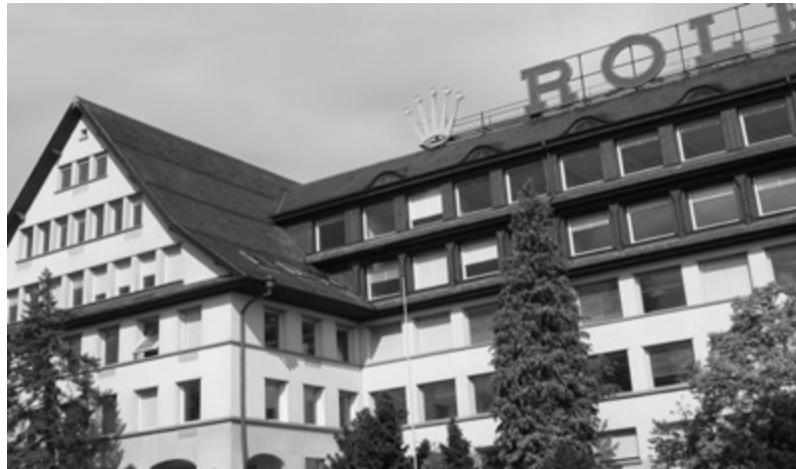
Siège de Sputnik Engineering AG dans l'ex-bâtiment Rolex, à Bienne, métropole de l'horlogerie, Suisse.
